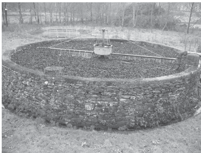
شکل ۴: نمایی از یک سیستم صافی چکنده
